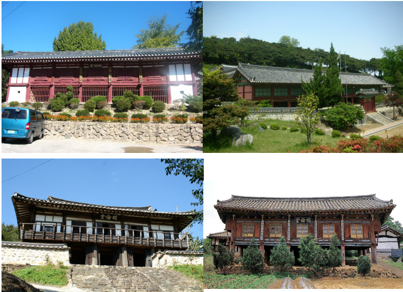
〈그림 4〉 향교의 누각형 명륜당의 사례 (담양향교, 강릉향교, 회인향교, 옥곡향교 명륜당)
